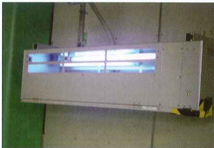
自動捕虫紙交換型ライトトラップを利用することで、大量に虫を捕獲する場所や週間ごとのモニタリングが必要な箇所を管理
