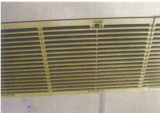
衛生エリアのエアコン噴出し口に埃が溜まっている。この埃が落下すると、異物混入になり得る。また、エアコン内部で発生したカビの胞子が製品に付着すると、製品の消費期限内にカビが発生する危険がある。
