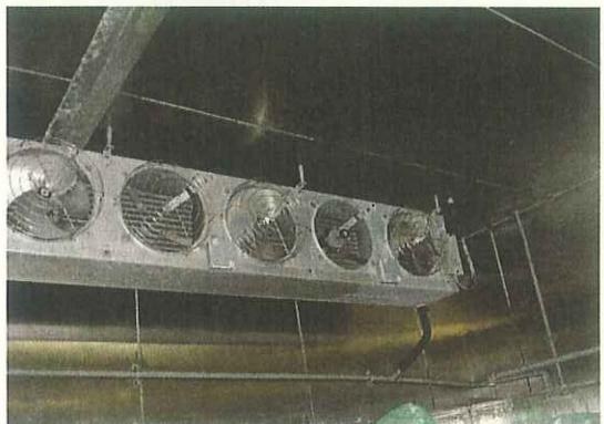
冷蔵庫内の結露が製品に落下することにより、微生物汚染が発生した場合、想定した最終製品の初発菌数をオーバーする可能性がある。
