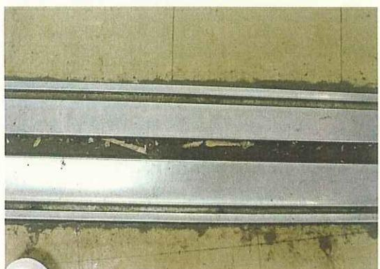
製造区画内の床溝において、清掃不備によるゴミ溜まりが確認された場合、その箇所は害虫生息ができる状態になり、害虫発生指数をオーバーする可能性がある。
